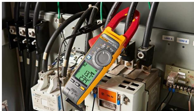
Dijital pens ampermetre ile akımın ölçülmesi
