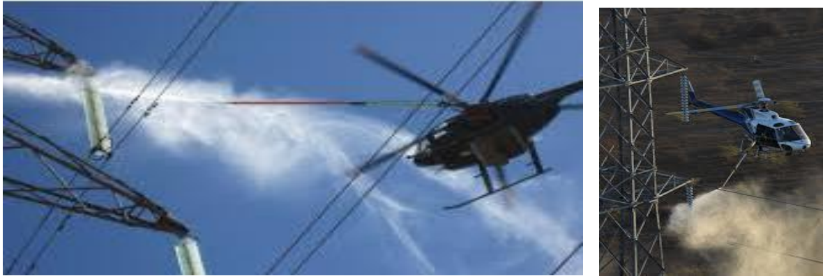
Şekil 3. Enerjili iletim hattındaki izolatorlerin helikopterden yıkanması
