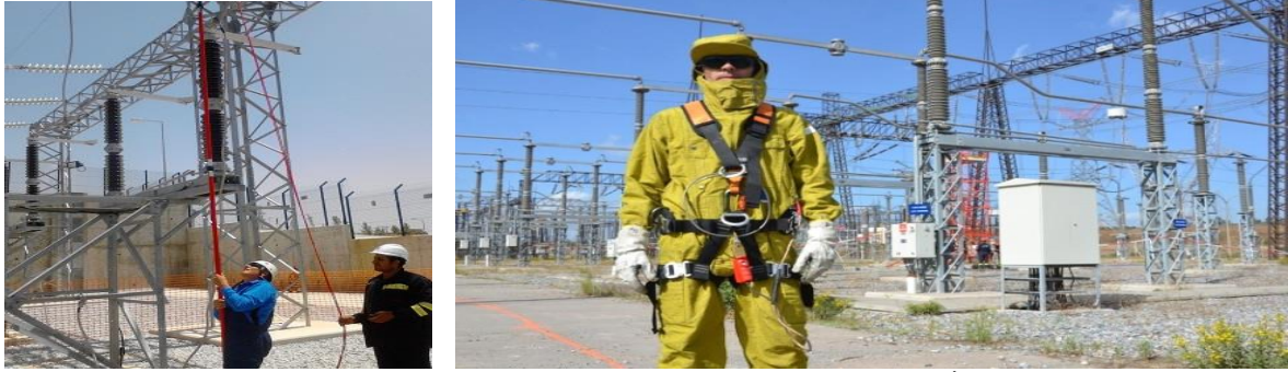
Şekil 1. Transformator merkezinde canlı bakım (TEİAŞ)
