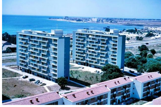
Şekil 3. Ataköy 2. Kısım apartmanlarına ait görseller (Örnek, 2021)
