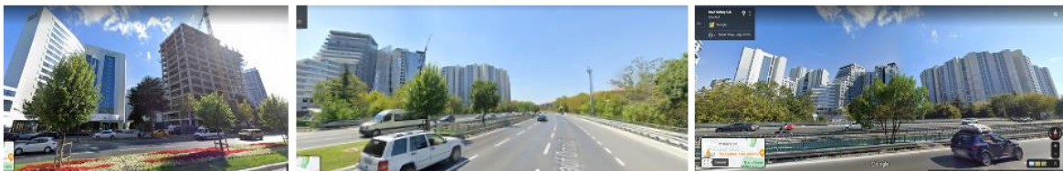
Şekil 5. Ataköy 2. kısımdan Ataköy Konaklarına kadar Rauf Orbay Caddesi (sahilyolu) üzerindeki yapılara ve yapılmakta olan inşaatlara ait görseller 47 (URL-3)
