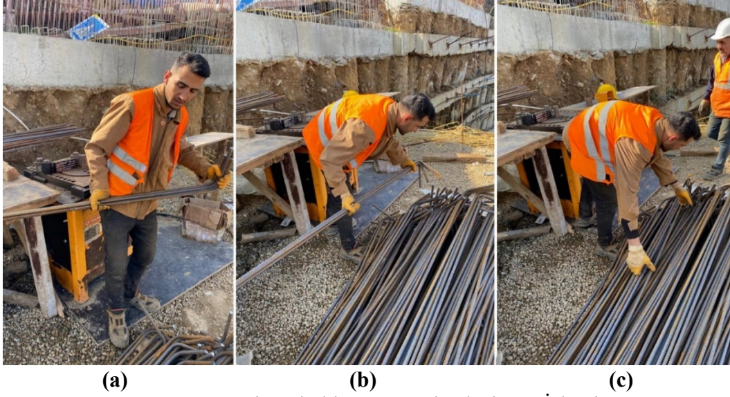
Şekil 3. Demir Çubukların Boyutlandırılması İşlemi
