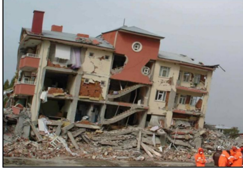
Şekil 1. Deprem sonrası oluşan yıkıntı atıkları (Balaban, 2014)
