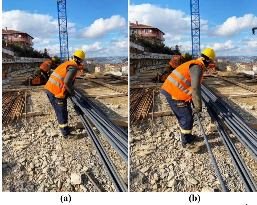
Şekil 1. Demir Çubukların Şekillendirme Tezgahına Elle Taşıma İşlemi
