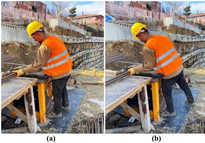
Şekil 2. Demir Çubukların Şekillendirilmesi İşlemi
