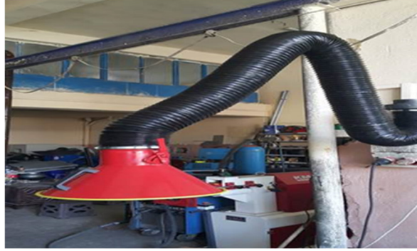
Şekil 6. Yerel Havalandırma Sistemi
